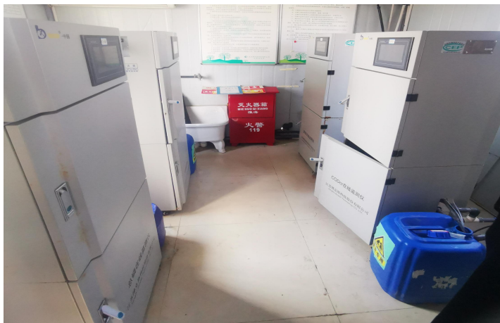
图 4.1-8 厂区污水排放口在线监测设施
