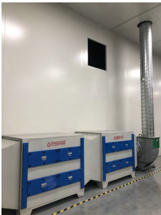
纺丝废气配套二级活性炭吸附+排气筒
