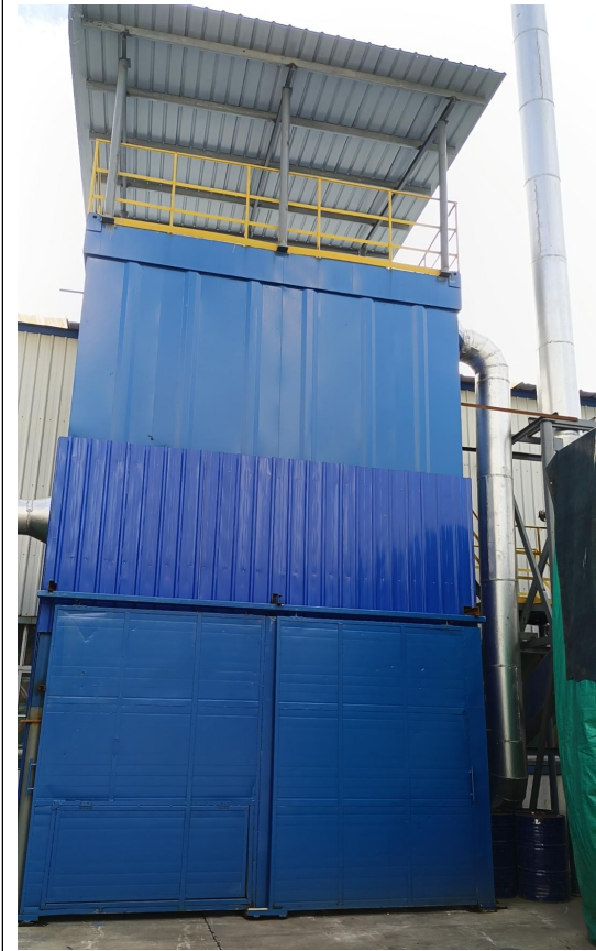
锯切工序脉冲式布袋除尘器
