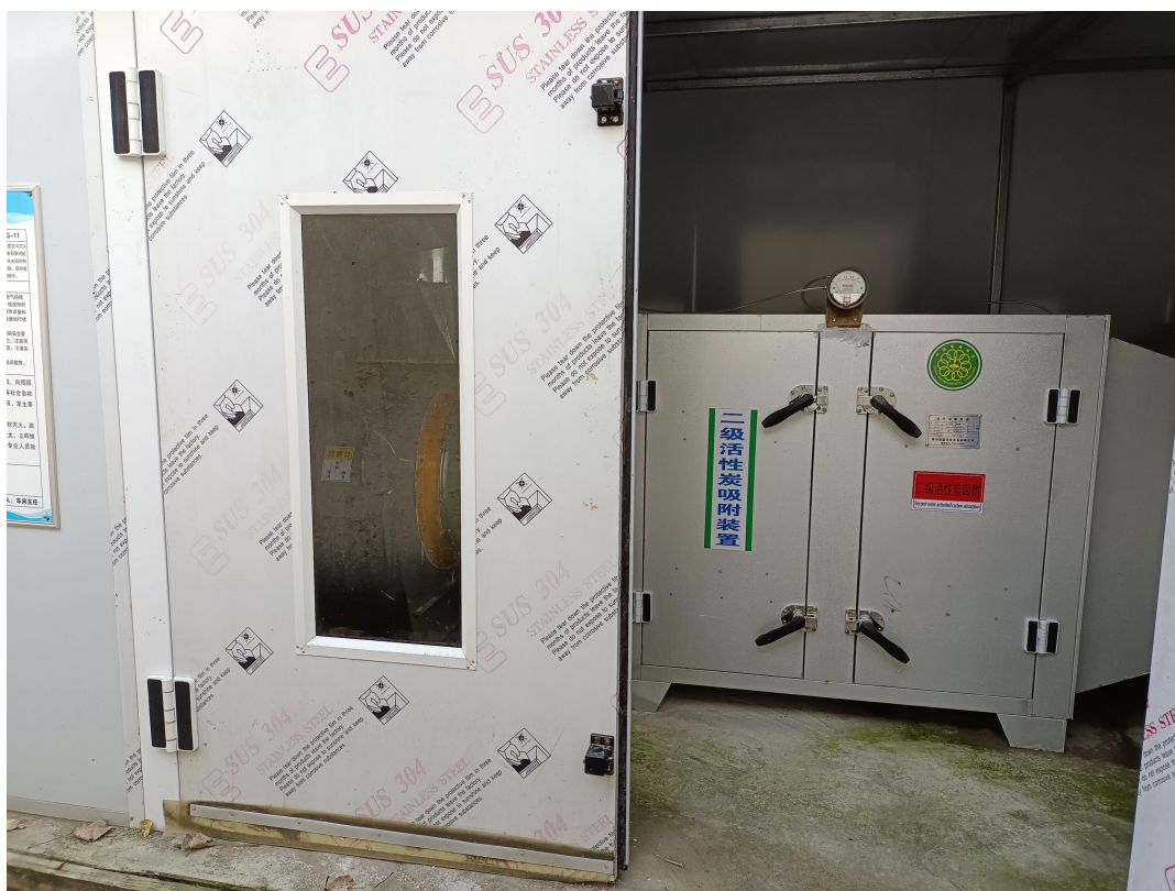
涂胶工序过滤棉+二级活性炭吸附装置
