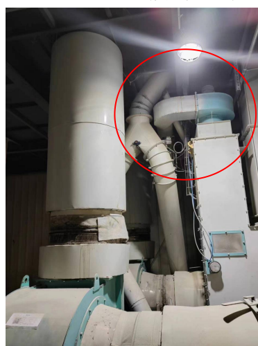
制粒冷却工序废气处理设施进口
